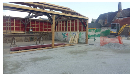
Pendant les travaux
