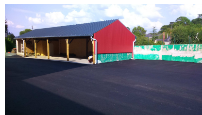
A la fin des travaux
